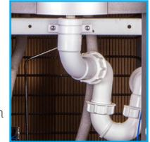
Système de traitement pompe. Une pompe permettant le rejet des eaux usées de bac égouttoir jusqu' à 100 mètres horizontalement et de 5 mètres verticalement (Installe en usine).
